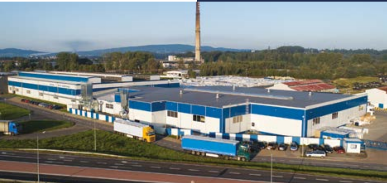
Fabrik für Verbundplatten, Gorlice
