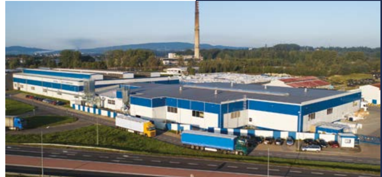
Fabrik für Verbundplatten, Gorlice
