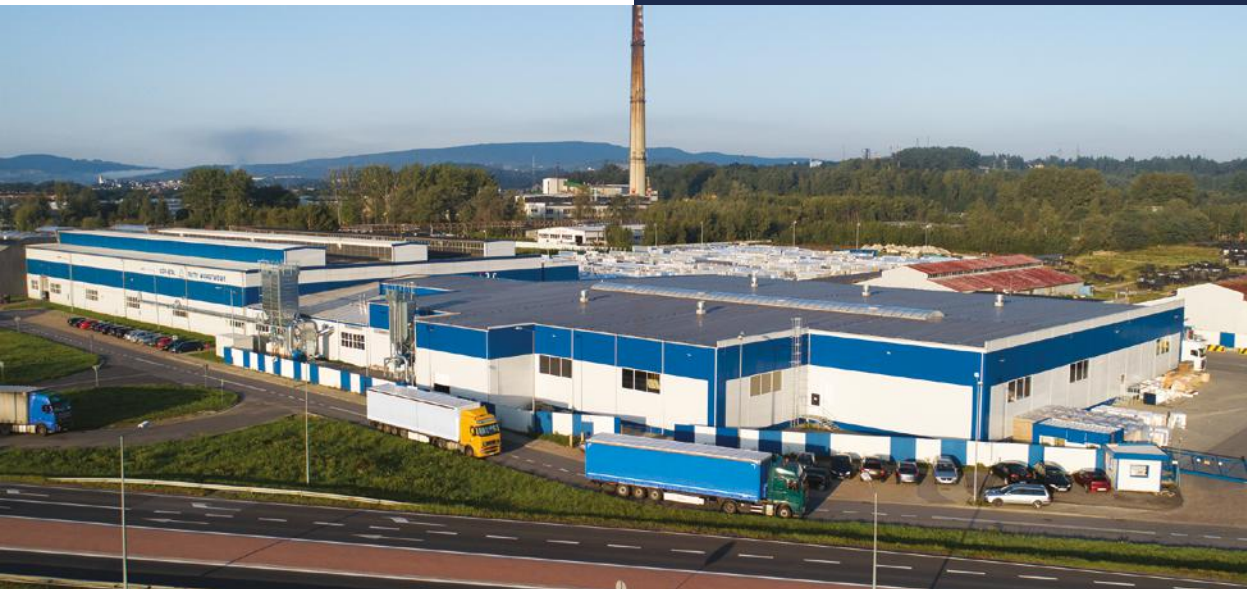
Fabrik für Verbundplatten, Gorlice
