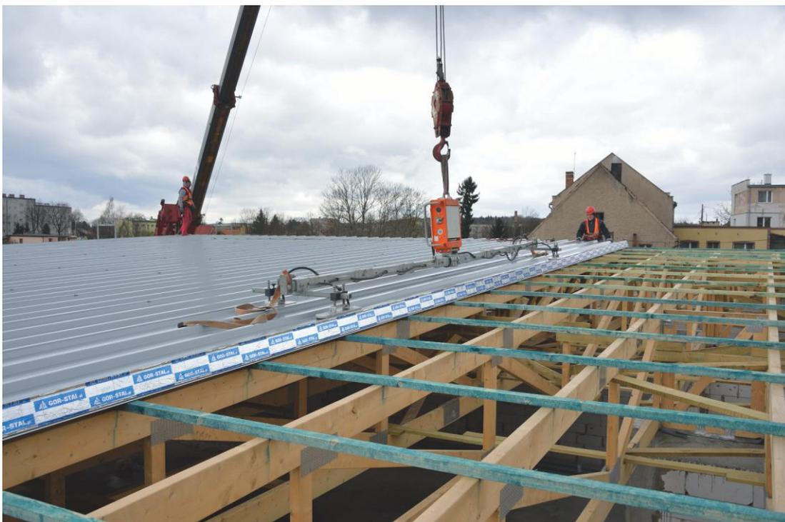
▷ 1. Raccordement de la rainure GS MW avec la languette GS insPIRe
