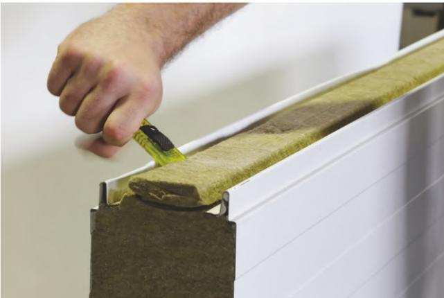
**Photo 3:** Moyen proposé pour retirer la languette du panneau GS MW
