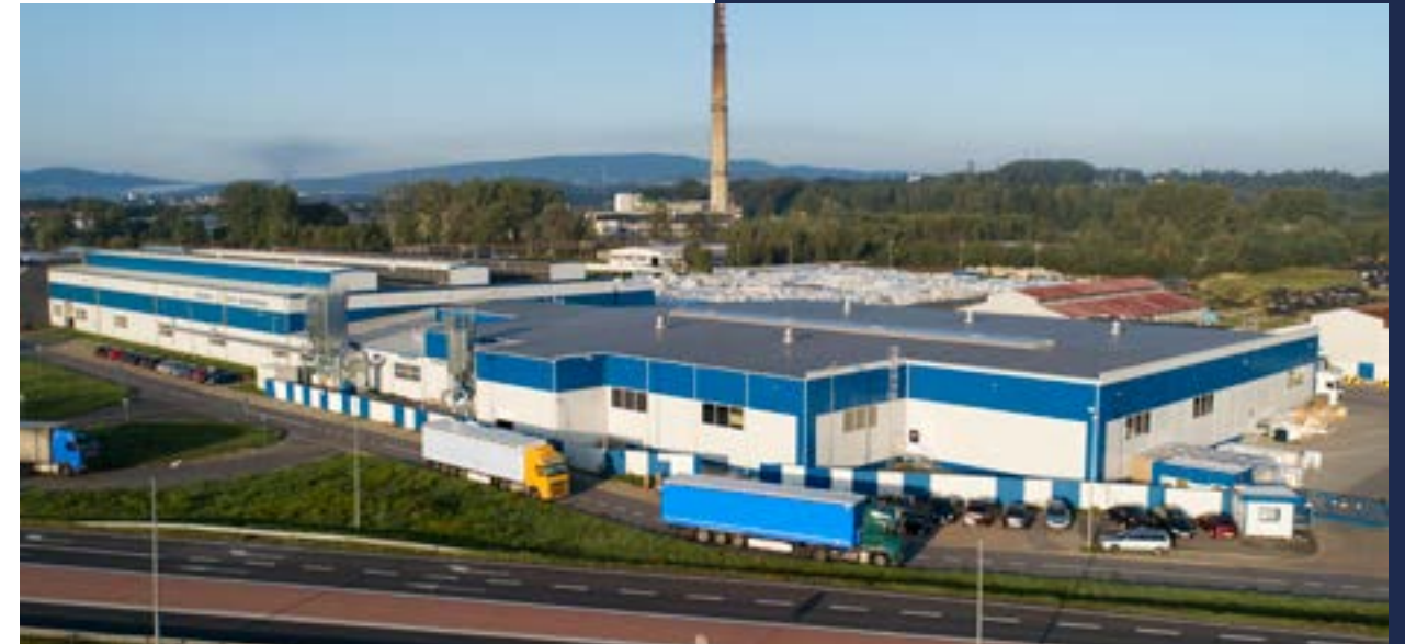
Fabryka Płyt Warstwowych, Gorlice
