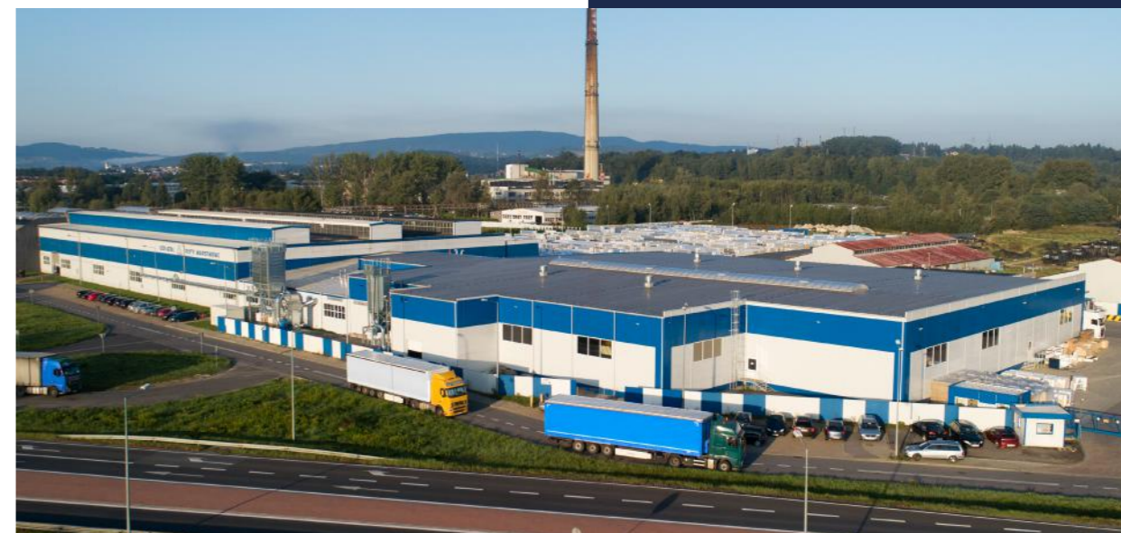
Fabryka Płyt Warstwowych, Gorlice
