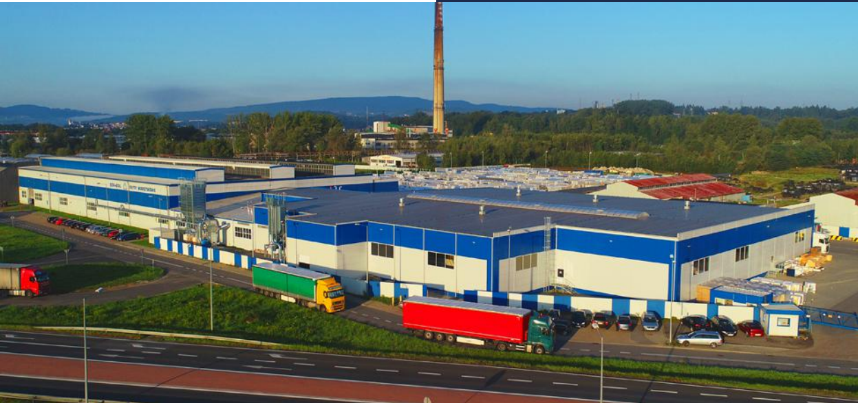
Fabryka Płyt Warstwowych, Gorlice
