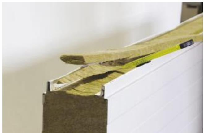
**Фотка №3.** Предлагаемый способ удаления шипа панели GS MW
