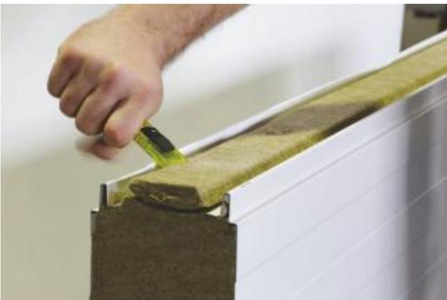
**Фото №3.** Предлагаемый способ удаления шипа панели GS MW
