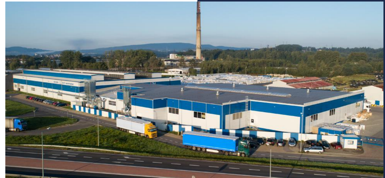
Завод сэндвич панелей, Горлице
